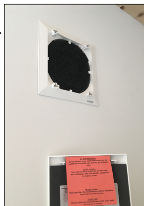
Abnehmen der inneren Abdeckung.
