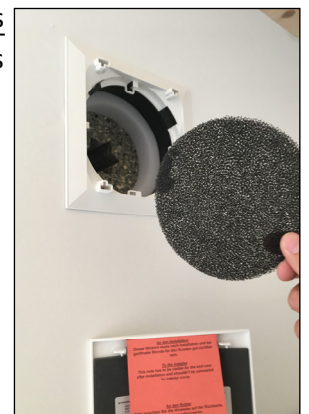
Herausnehmen des zu reinigen Filters
