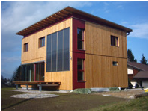
Abbildung 1: Passivhaus in Holzbauweise (Bildquelle: Weissenseer Holz-System-Bau GmbH)
