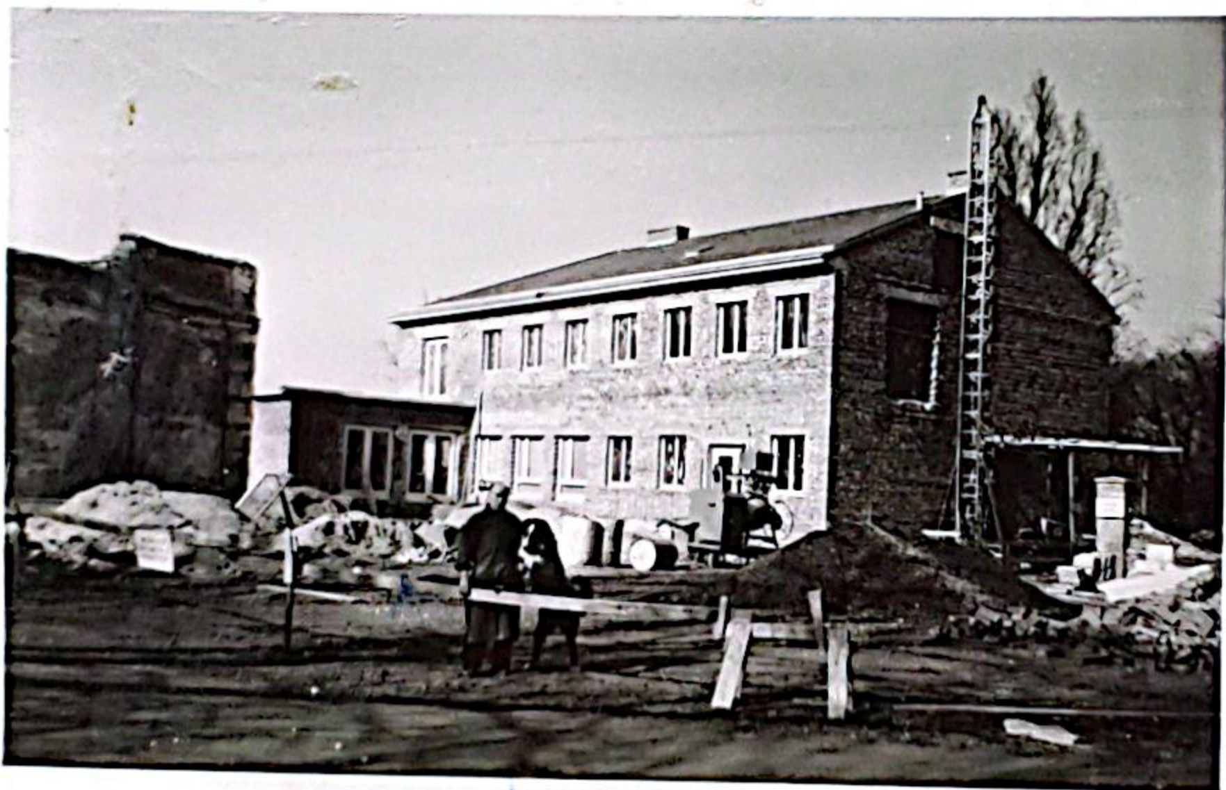
Westliche Windschutz- mauer Kindergarten Schwestern Kloster (an der Stelle des alten Daniel Gran-Saales).
