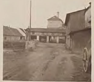
Werkstattshof in Glévinthalen im Hintergrund des 1945 durch eine Bombe
